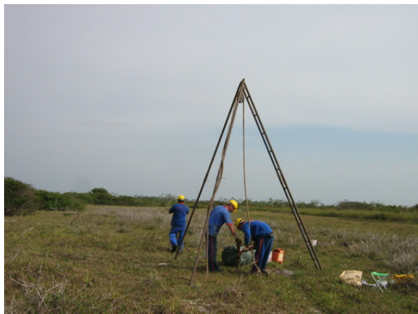
Fotos 5.3.5.1.1-1 e 5.3.5.1.1-2: Execução de sondagem em PZ-2b.
