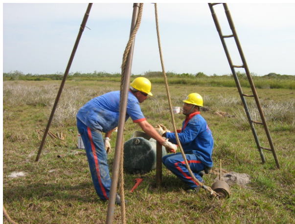
Fotos 5.3.5.1.1-1 e 5.3.5.1.1-2: Execução de sondagem em PZ-2b.
